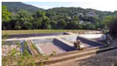
Mise en eau de la nouvelle station d'épuration à Collobrières.
