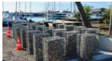
Installation de nurseries à poissons dans le port Miramar à La Londe.
