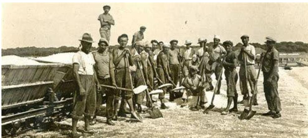
Jusqu'au début du XXe siècle, la récolte s'effectuait à même le sol (**à fleur de boue**). Le sel était ramassé et porté dans des paniers (**les banastes**) jusqu'à la zone de stockage (**le gravier**) où il était entreposé sous forme de camelles. Puis les banastes ont été remplacées par des brouettes. Après 1945, chaque salin va créer son propre récolteur mécanique afin de limiter la main d'œuvre.
